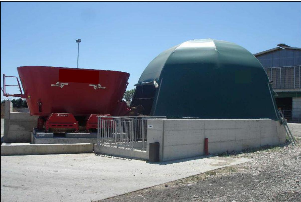
*Figura 5 Tramoggia di carico in legno, abbinata a digestore a tetto fisso*
