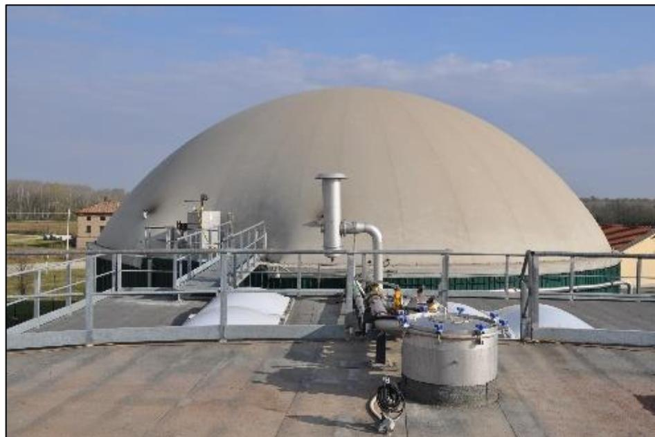
*Figura 12 Vista valvola di sicurezza – Guardia idraulica*
