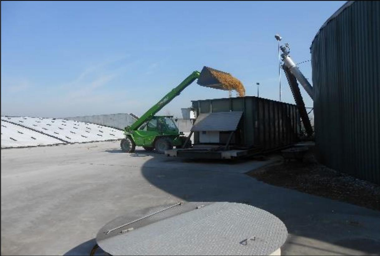
*Figura 4 Tramoggia di carico vicino a vasca di omogeneizzazione abbinata a pompa trituratrice*
