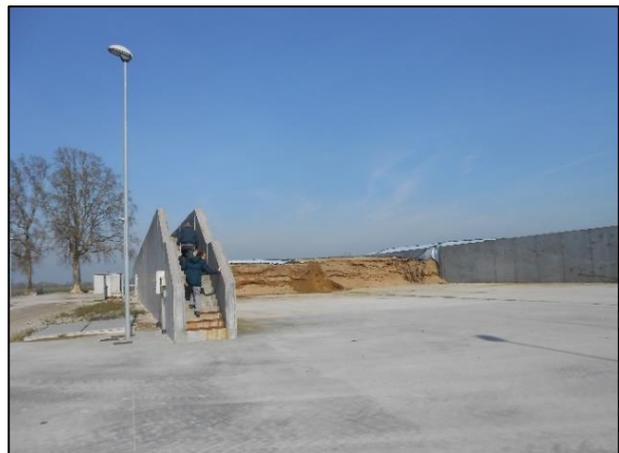
Figura 2 Trincee per lo stoccaggio degli insilati. In questo caso la particolare conformazione dei muri di contenimento consente di effettuare le manovre di posa e rimozione dei teli di copertura in condizioni di sicurezza
